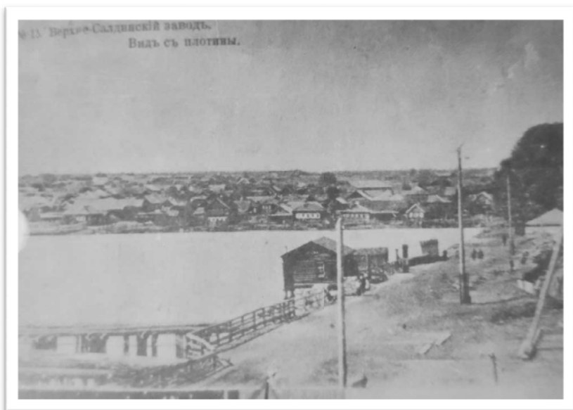
Вид с плотины Верхнесалдинского завода
